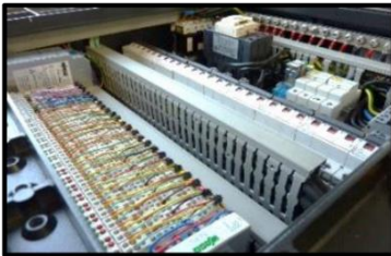
Ilot Ethernet intégré dans la baie
